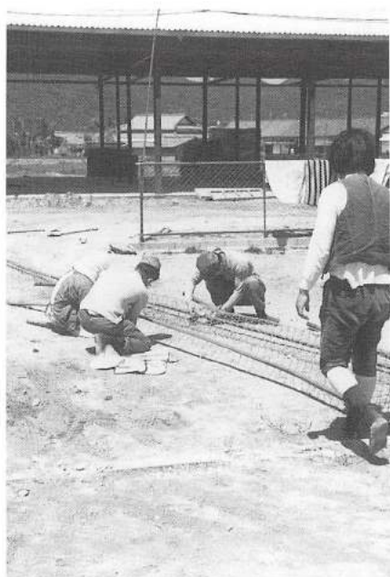
昭和45年、最初の岡山工場（現・和気工場）の建設始まる
