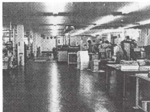
操業間もない新潟城南電器の第3棟(上) と工場内装風景(下)
